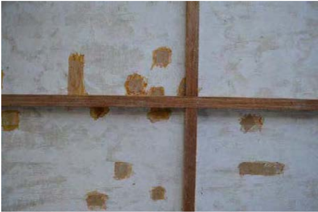
Detalle de los parches para tapar hoyitos
